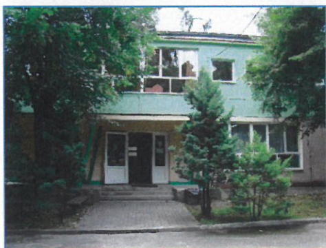
Zdjęcie 1. Przedszkole Publiczne w Zawidowie
