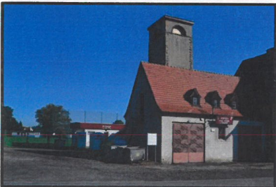
Budynek remizy strażackiej przy ul. Wilczej 12 w Zawidowie
