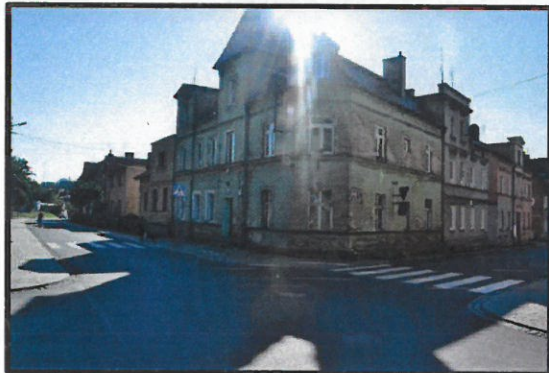
Ulica Wilcza – widok od strony ul. Parkowej.
