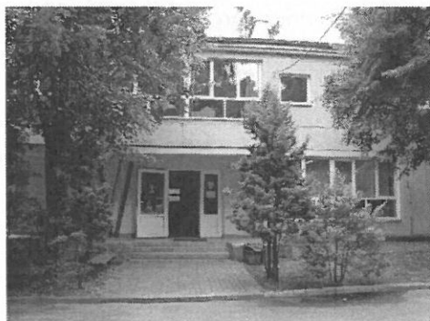
Zdjęcie 1. Przedszkole Publiczne w Zawidowie
