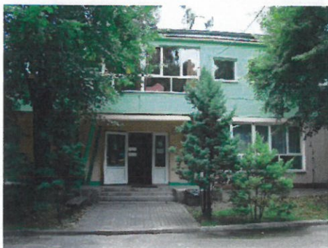
Zdjęcie 1. Przedszkole Publiczne w Zawidowie
