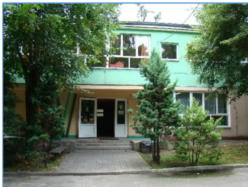
Zdjęcie 1. Przedszkole Publiczne w Zawidowie
