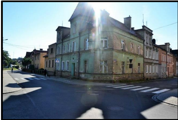
Ulica Wilcza – widok od strony ul. Parkowej.
