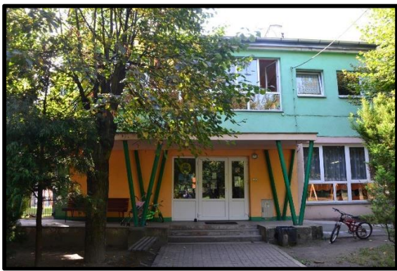
Budynek Przedszkola Publicznego w Zawidowie, ul. Parkowa 2
